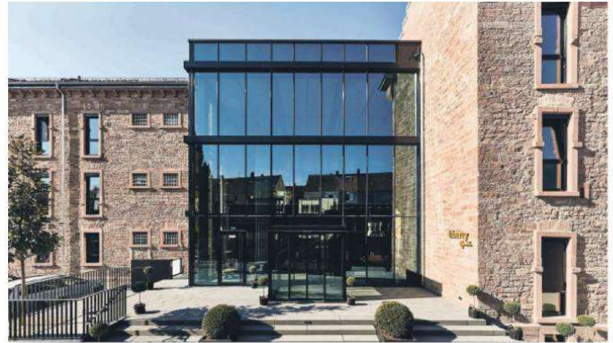
Hell und einladend: Ein Glaskubus verbindet die beiden ehemaligen Zellenblöcke. FOTOS: HOTEL „LIBERTY“
