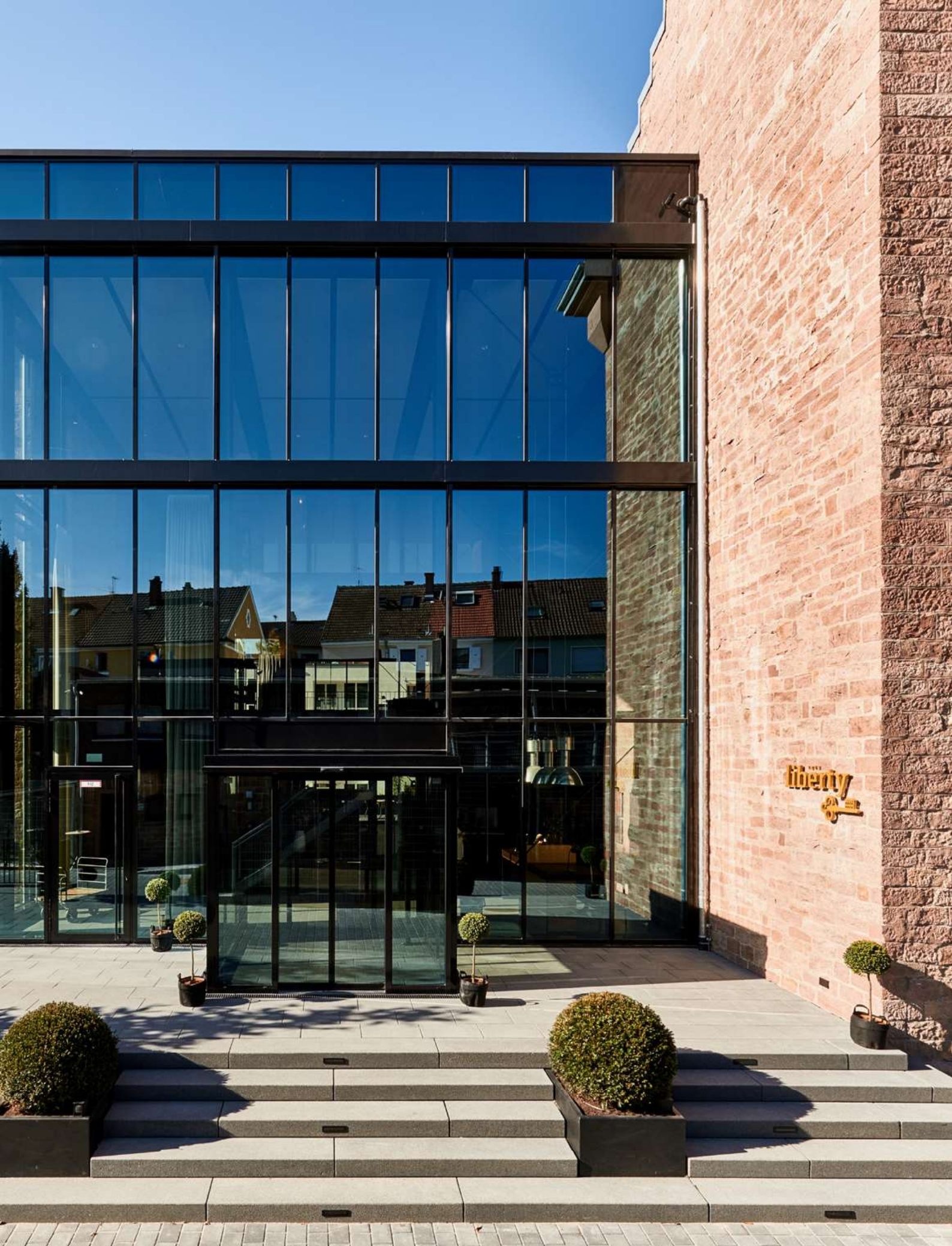
Das unter Denkmalschutz stehende Gebäude, das Mitte des 19. Jahrhunderts entstand, diente bis 2009 als Gefängnis, wurde dann saniert und öffnete 2017 als Hotel-Restaurant.
